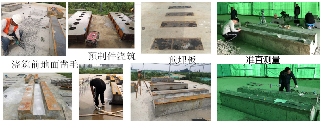
浇筑前地面凿毛 预制件浇筑 预埋板 准直测量 铸件灌浆后 浇筑前界面冲洗 现场就位调平 振动测试
