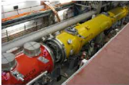
> 3 rd harmonic sc module 3.9 GHz
