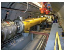
Während der letzten Wartungspause: Einbau des Beschleunigermoduls Nr. 6 in den FLASH-Tunnel. During the last shutdown: Installation of accelerator
