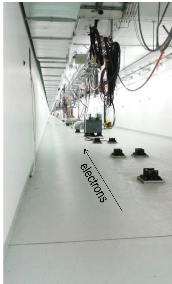
Tunnel: BC1 ( z \sim 60 m)
